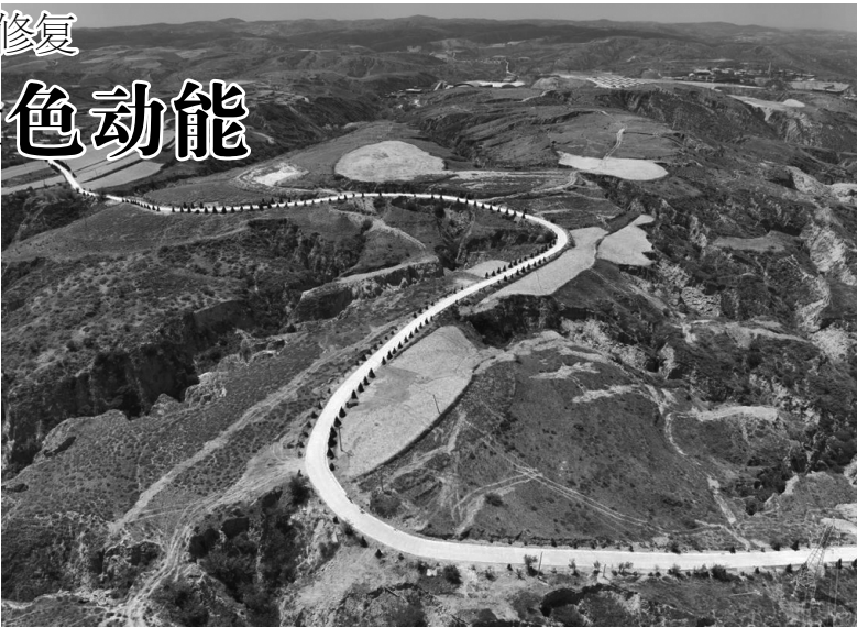
瑞泰 2023 年生态修复项目—35105 工作面采空塌陷区道路修复
