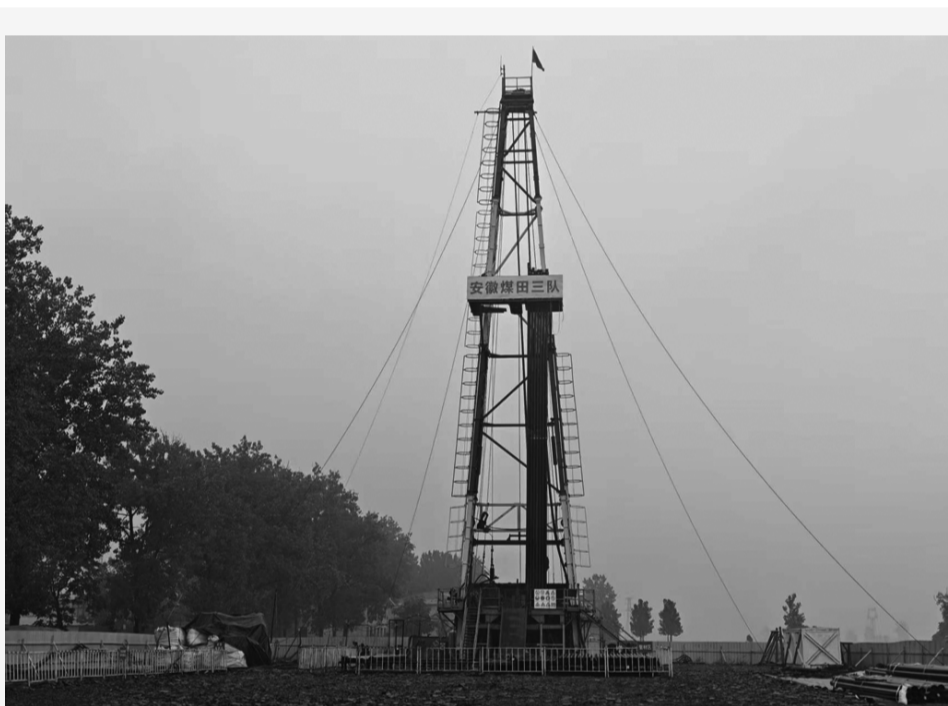
近日,安徽省煤田地质局三队承建的安徽省亳州煤业有限公司信湖煤矿南翼大巷及 82 采区上山地面定向钻超前探查掩护工程正式开工,该工程共设计 4 个井场、5 个孔组及 33 个分支孔(含 3 个机动孔),钻探工程量 15800 米,预计注水泥 10000 吨,总工期 180 天,旨在查明南翼大巷及 82 采区上山过断层区域断层发育情况,并对巷道过断层区域围岩进行注浆加固,确保巷道安全施工。 董传霞 张鑫 摄影报道
