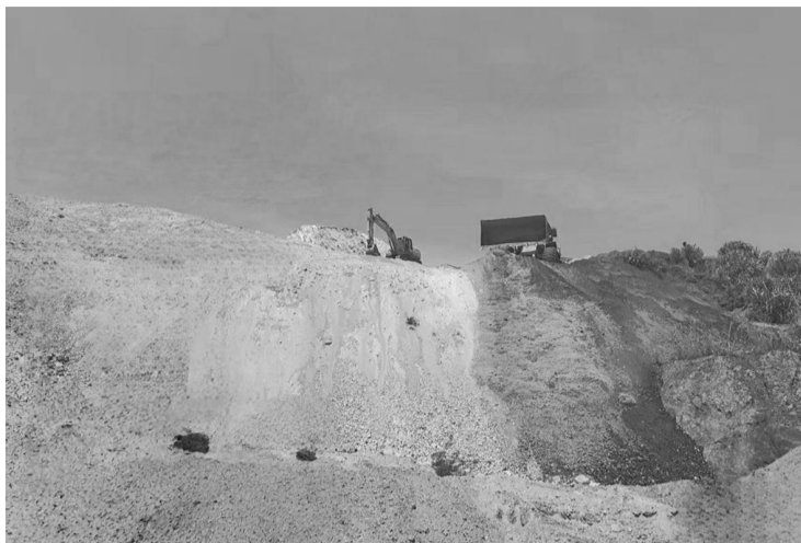
永新县埤前镇燕溪溶江采石场1矿点削坡作业现场 艾散·麦麦提摄
