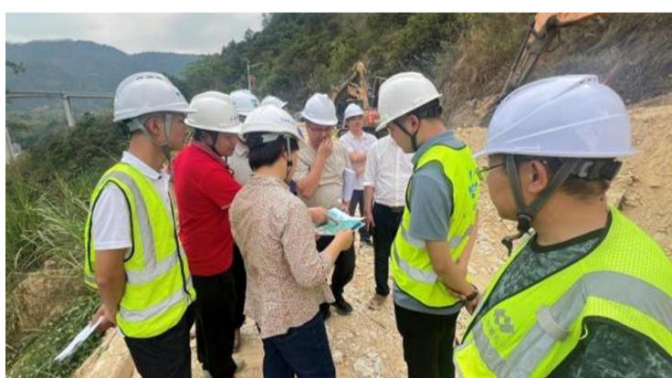
中煤江南一党支部平塘地质灾害点治理项目问题查摆现场
