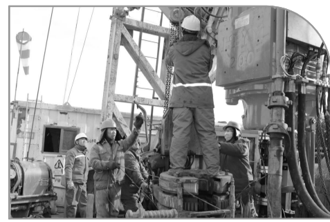
钻机平台上一派紧张施工景象
