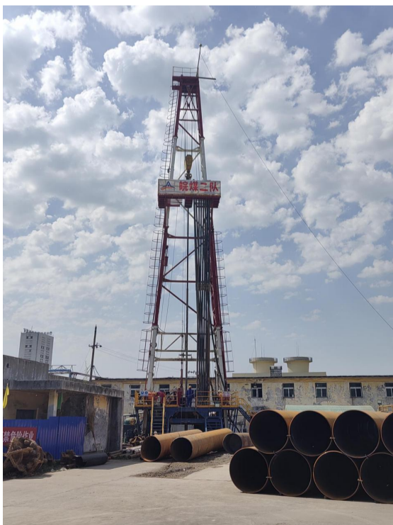
淮北地面瓦斯抽采系统改造管道井工程
