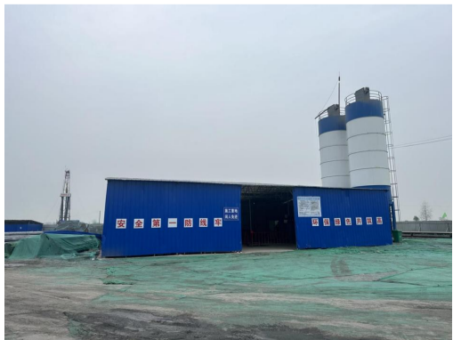
杨柳煤矿1056风抽巷地面向超前探查掩护工程
