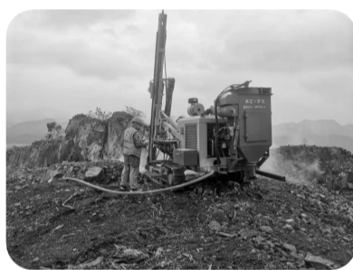
东乡区王桥片区生态产品价值实现工程施工现场 张超 摄
