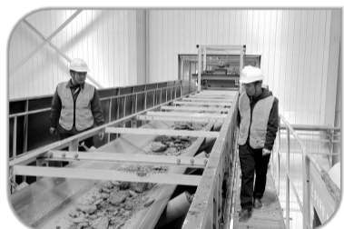
陕煤地质天地公司小保当项目正在进行矽石充填
