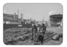
近日,山东省煤田地质局物测队承担的湖北 省孝感企业场地物探数据采集项目竣工。技术人 员克服电磁噪声干扰严重、地下潜水位较高等不 利因素,在总面积18016平方米的施工区内施工 8个地块。完成测线探测 74条。总计长度 3961 米,查明了区域内地下基础、隐蔽管道、老旧混凝 土等分布情况,为厂区重建及规划工作提供了可 赵 欣 王家琪 摄影报道
