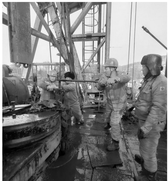
春节期间,山东省煤田地质局一队职工坚守在大唐岭地质灾害探查项目施工一线,在做好防寒、防冻、安全等相关工作的基础上,顶风冒雪,坚守岗位,确保生产作业安全有序开展。郭洪良 摄影报道
