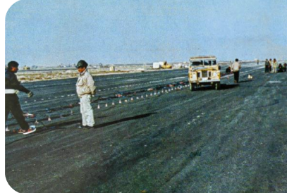
1996年，物探院开展首个国际项目——伊朗霍梅尼机场浅层地震勘探项目
