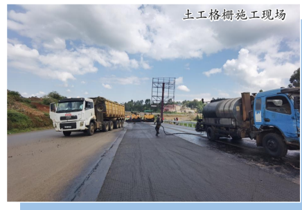
土工格栅施工现场
