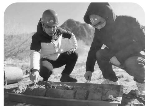
李澎(左)检查抽水蓄能电站建设项目坝址区岩芯
