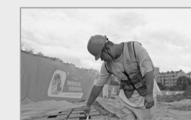
在总局江苏局长江基础公司无锡XDG-2022-92号地块开发建设项目桩基及基坑支护工程现场，施工员赵知衡正顶着酷暑检验格构柱的尺寸。公司在工期紧、场地狭窄的情况下，高标准、高效率、高质量推进该工程，获得建设单位领导及现场管理团队的一致认可。 费莉
