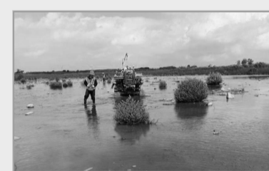
近日，因连续暴雨，总局江苏局徐州工勘院施工的盐城化工生态园区调查项目现场出现大面积积水，设备行进困难。该院现场成立党员突击队，严格按照安全规程中涉水作业规定开展工作，同时启动项目备用抽水设备，为园区排水贡献力量。 朱绍娟
