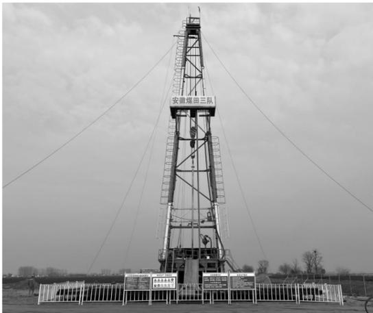
3月31日,安徽省煤田地质局三队施工的淮北矿业股份有限公司芦岭煤矿-900大巷地面区域探查治理工程4#井钻孔开钻。该工程设计钻探总工程量5419米,预计注水泥5000吨,计划工期154天,将采用“地面向斜钻孔”施工法对穿灰岩区域及靠近断层带附近巷道的顶部、底板及两侧进行注浆加固,设计垂直主孔1个,治理孔2个,探查孔2个,机动分支孔1个。
