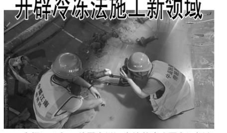
本报讯 近日,总局中煤江南特种分公司在深圳城市轨道交通16号线福坑站至安良站区间的联络通道项目中,创新采用自主设计的冷冻法施工工艺,取得良好施工效果。该工艺与传统施工方法相比,不仅安全无污染,而且提高了效率,为城市轨道交通建设领域提供了新的解决方案。
