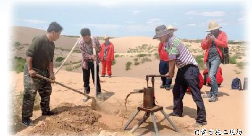
内蒙古施工现场
