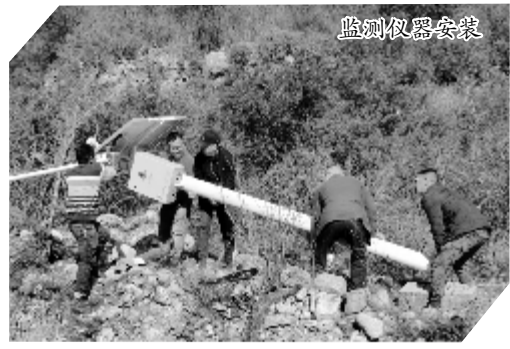
监测仪器安装
