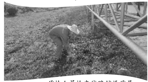
质检人员检查线路铺设质量
