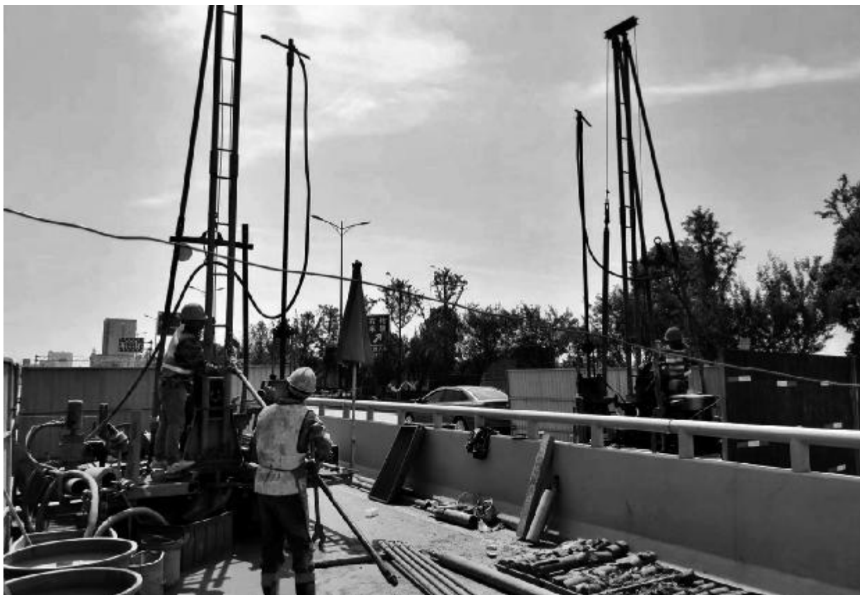
日前,湖南省工程地质研究所勘察设计院一分院承揽的湘阴东路东延(黄兴大道-机场大道)道路工程一标段,12台钻机正分别对230个孔位进行450米探孔施工。该项目位于长沙县,主路为城市快速路,设计速度80千米/小时,辅路为城市主干路,设计速度50千米/小时,拟采用高架+地面辅道的快速化设计,高架全长约9.07千米,主线和平行匝道跨路口根据跨路口宽度选择40—65米跨度。 李建平 摄影报道
