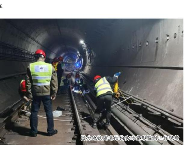
图为地隧结构实时变形监测工作现场
