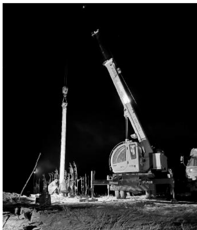
目前, 中煤一局集团有限公司山西分公司阳高县土地综合整治项目水源工程、管道工程、输配电工程全部展开施工。为保障水源工程井管夜间安装顺利进行, 项目部职工奋战在生产一线, 全过程参与项目进程管控, 保障项目进度。于子豪 摄影报道
