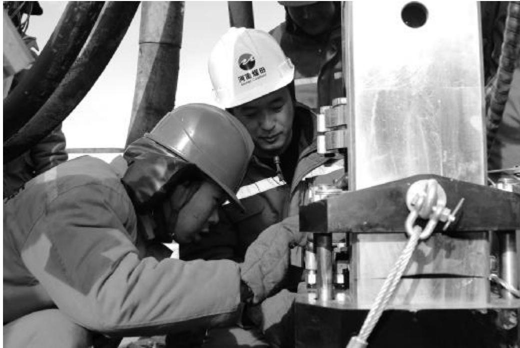
一月一日一大早，河南省资源环境调查二院工程分院在山西沁水开展煤层气钻井施工的职工们就开始了紧张的钻机安装工程。分院承担的亚美能源有限公司煤层气钻井工程，2021年共完成各类煤层气井92口，钻进工作量10.74万米。王伟旭 摄影报道
