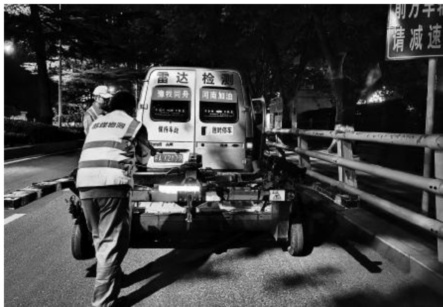
近日,为全力以赴为郑州灾后建设提供援助,江苏煤地地质物测队从西安、北京雷达检测工地抽调抢险救援人员,成立党员突击队,第一时间奔赴郑州,对中原区17条市政道路进行地下病害检测,进一步排除塌陷隐患,保障城市公共安全。 谷思勇 摄影报道
