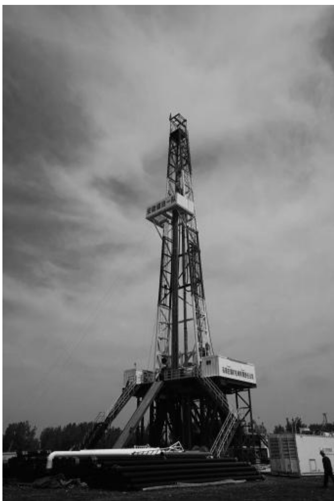
近日,安徽省煤田地质局一队承揽的淮南矿业集团煤层气开发利用有限公司朱集东煤矿1422(3)工作面地面瓦斯区域治理钻井工程正式开钻。该工程共设计施工2口L型钻井,均为三开型钻井结构,每口井井深约2100米,其中水平段长度约1000米,总工期160天。朱璐 摄影报道
