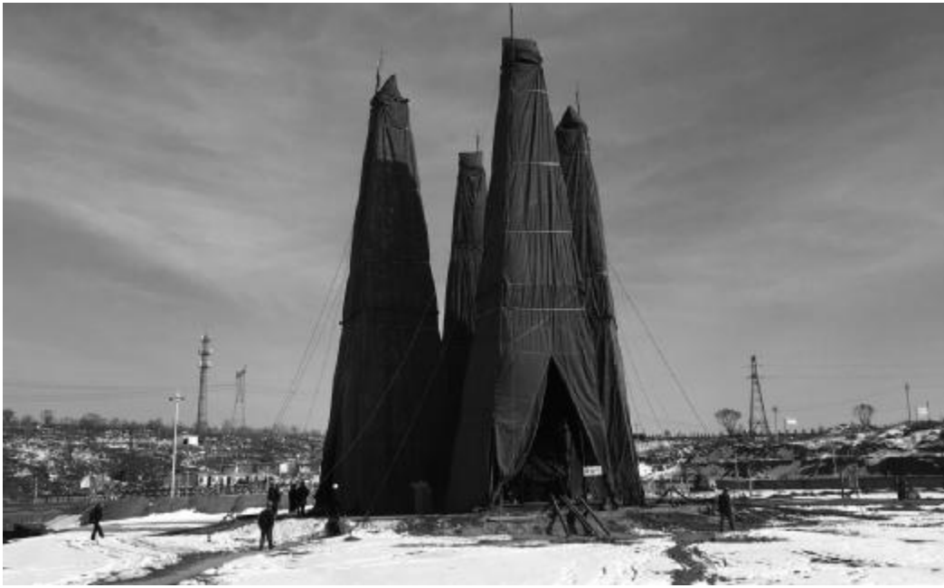
近日,由安徽省煤田地质局三队特钻公司承建的赵石畔煤矿项目立井和中央回风立井井筒冻结项目钻孔造孔工程开工。该工程立井井筒设计钻孔 63 个,钻探工程量 17945 米,工期 69 天;中央回风井井筒设计钻孔 69 个,钻探工程量 18926 米,工期 73 天,共投入钻机 8 台。 贾华峰 冯素素 摄影报道
