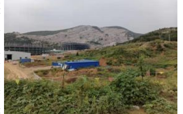
天津蔚州矿山地质环境综合治理二期工程
