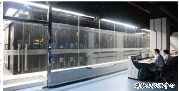
煤航大数据中心
