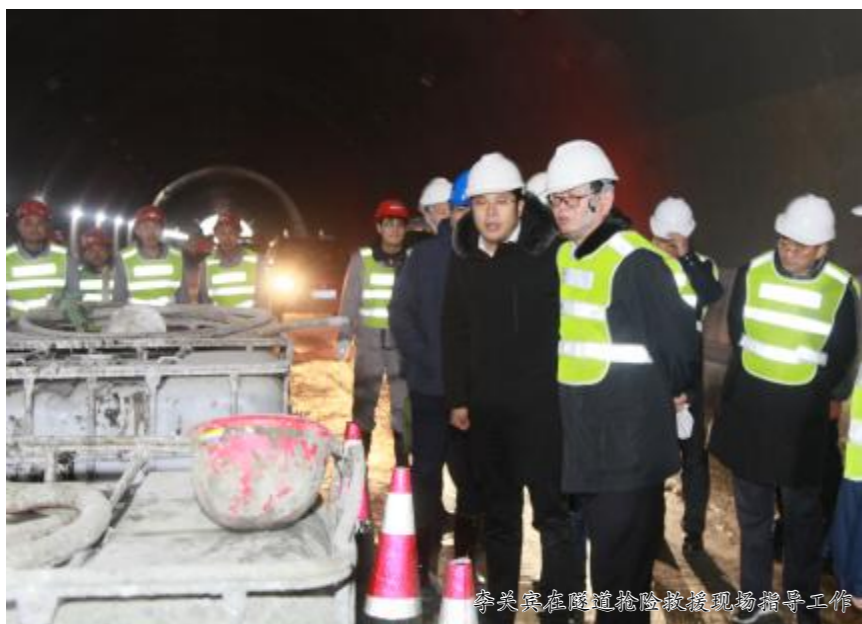
李关宾在隧道抢险救援现场指导工作
