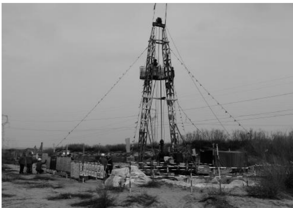
近日,陕西省一八五煤田地质局有限公司测绘中心邀请公司生产部安全部到榆林市第一人民医院标准化管理现场开展安全生产大检查。公司矿山地质工程处还进行了施工班组安全度牌,强化各项安全措施。刘宇新 杨万强 张春来 摄影报道
